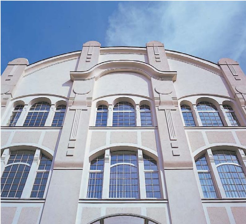
Einzigartige Perspektive: Mit viel Liebe zum Detail wurde diese Fassade erneuert.
